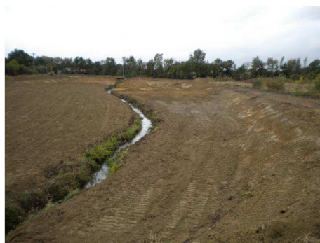
Le terrassement terminé
