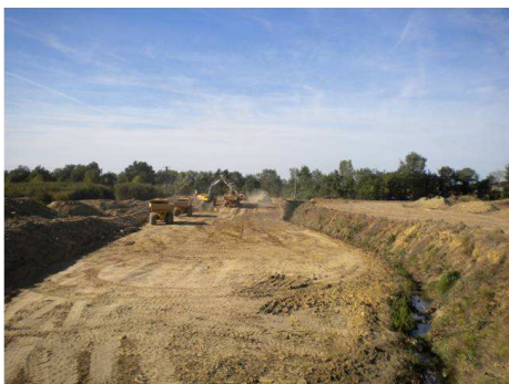
Le terrassement en cours
