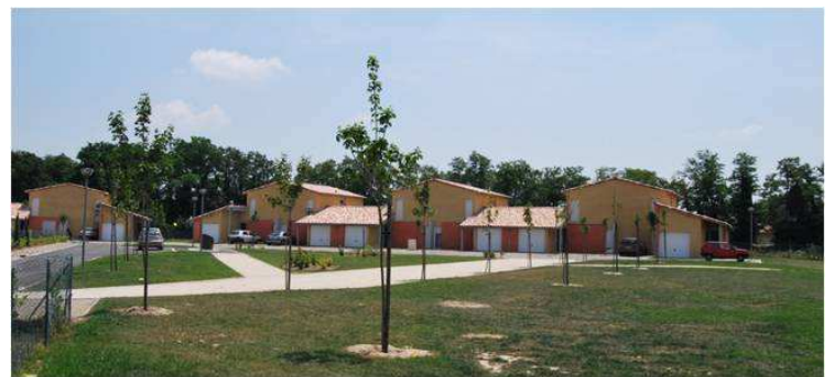
34 logements individuels et collectifs
